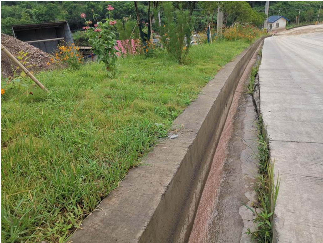
进口交通道路硬化、排水沟、边坡绿化
