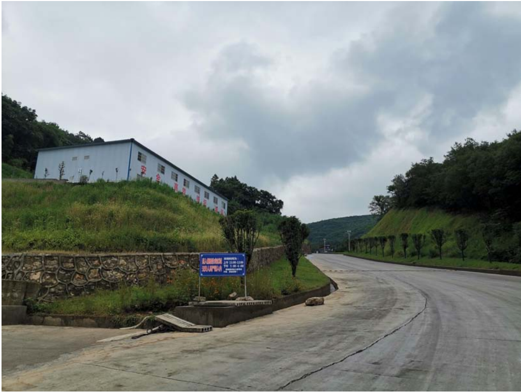
进口交通道路硬化、排水沟、边坡绿化
