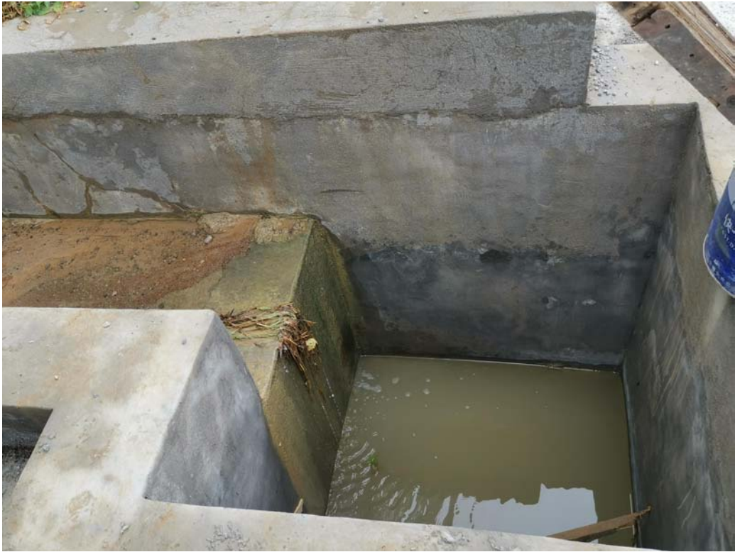
工业场地区沉砂池
