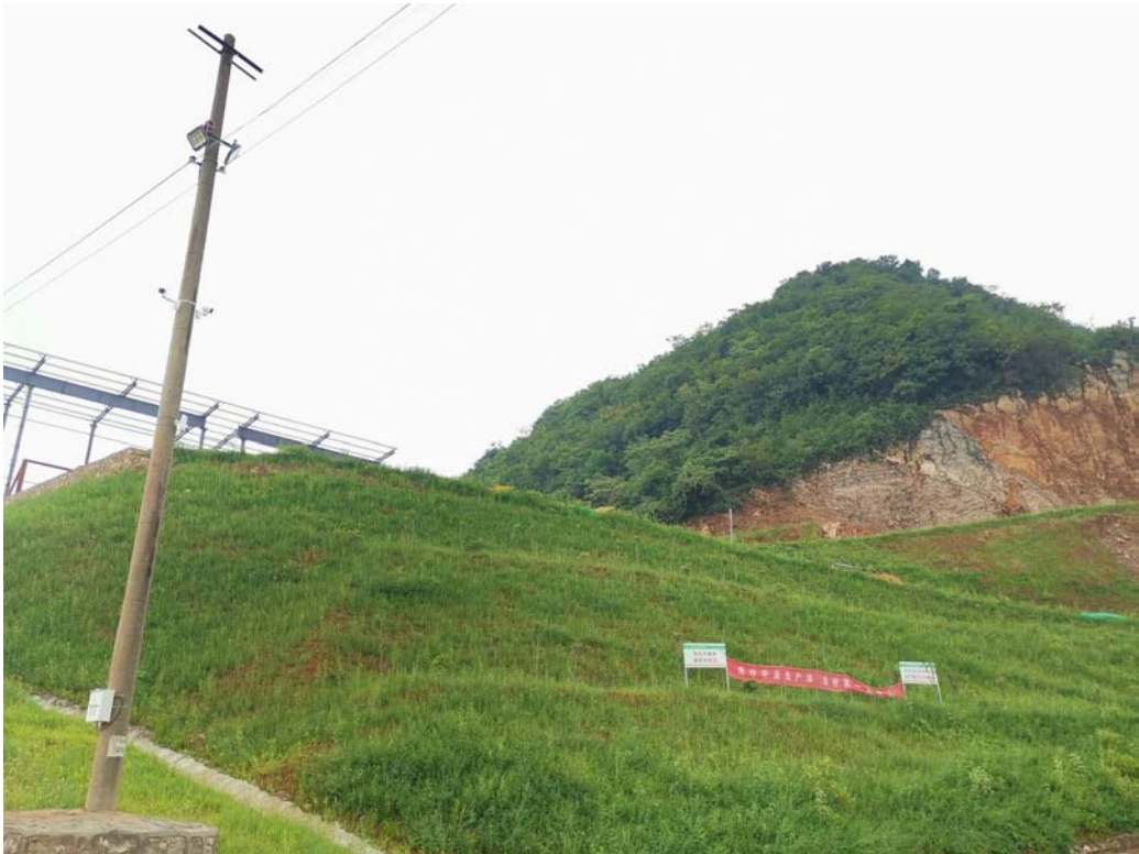
工业场地区边坡绿化
