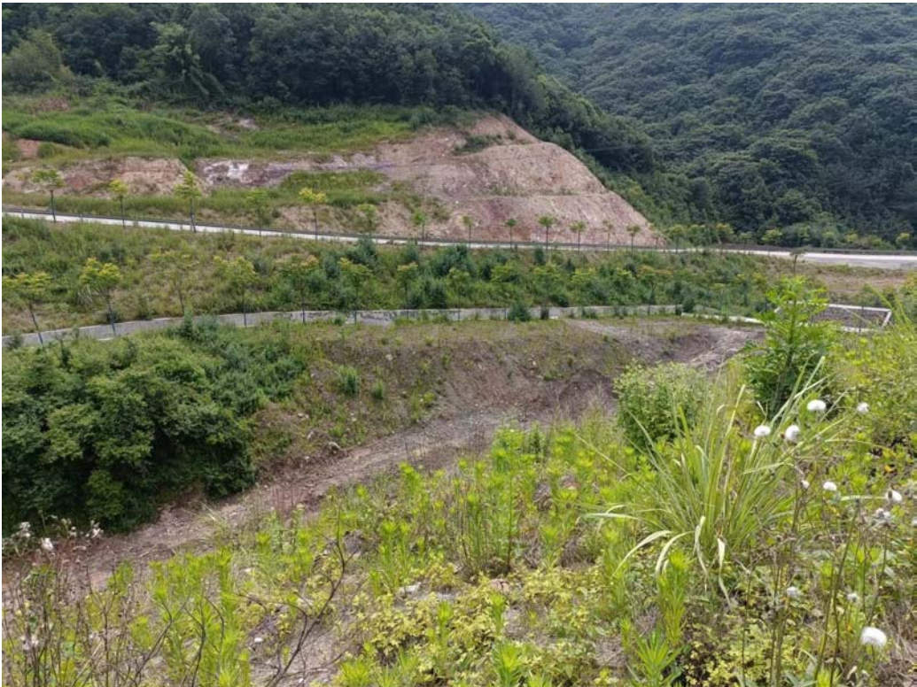
排土场区排水沟、绿化
