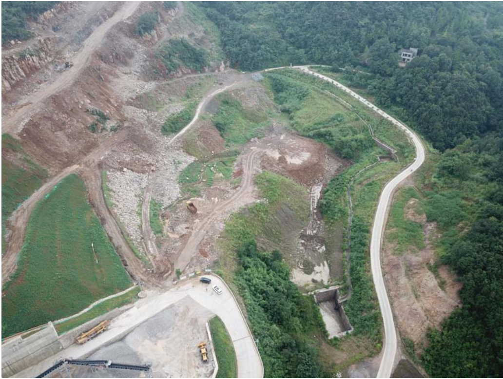
排土场区排水沟、沉砂池、绿化
