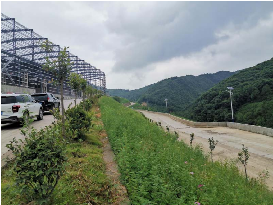
工业场地区边坡绿化
