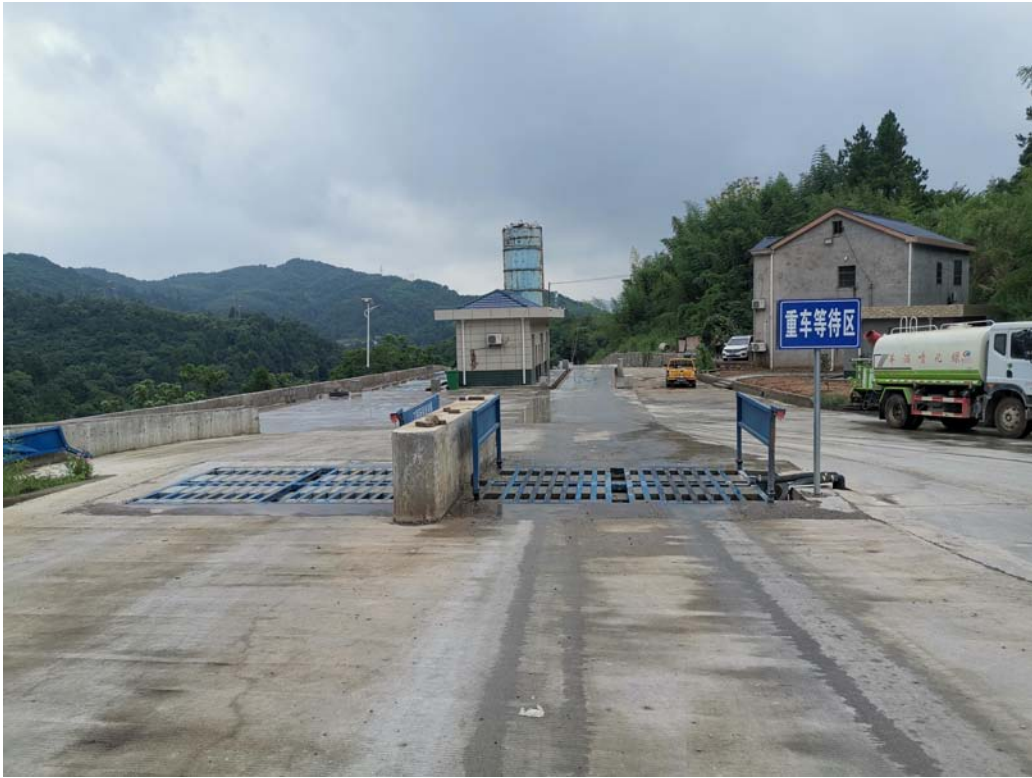
进口交通道路硬化、冲洗池
