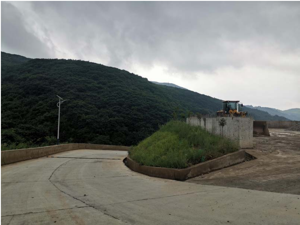
交通道路区排水沟、边坡绿化
