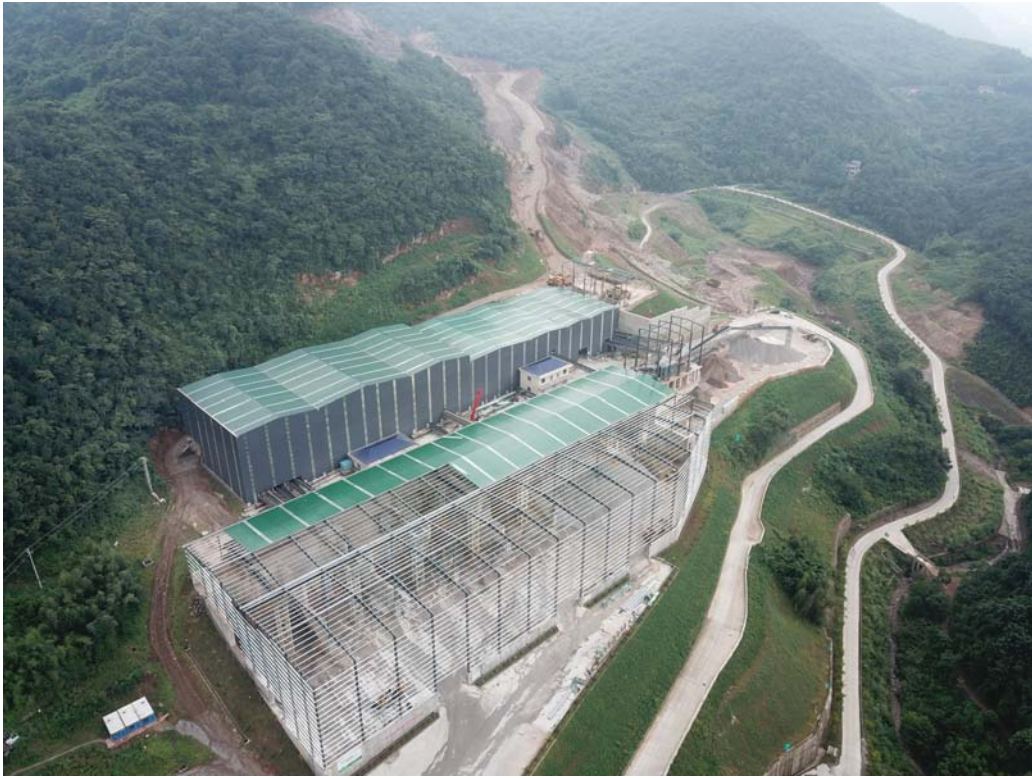
工业场地区、交通道路区硬化、排水沟、绿化措施
