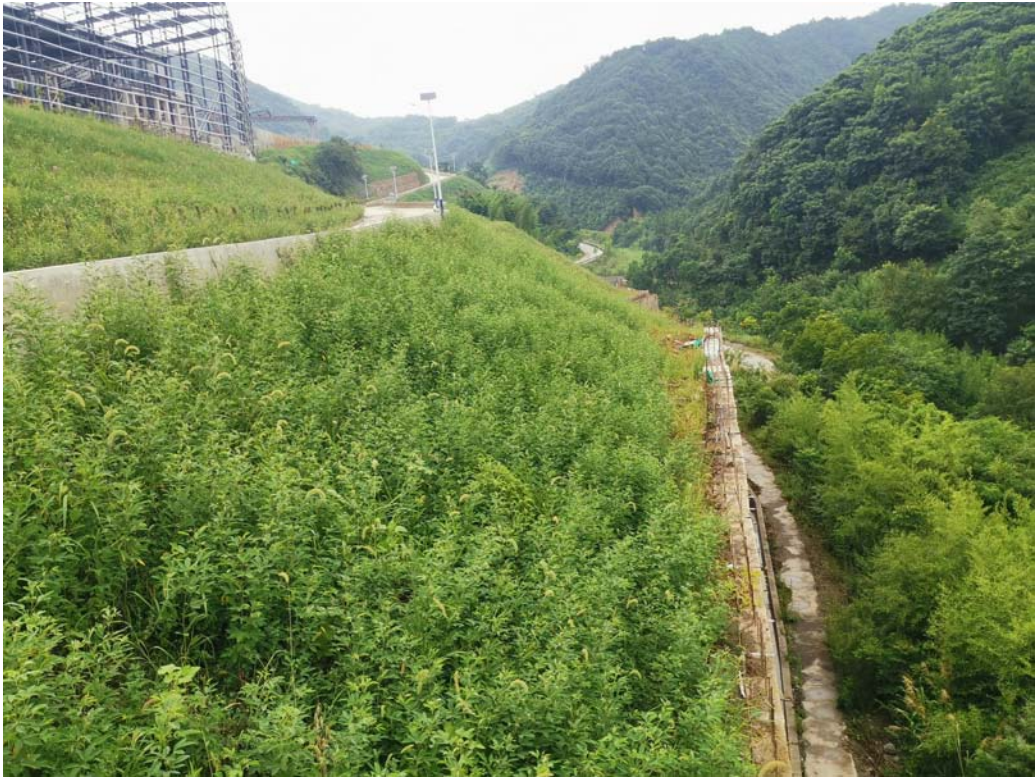
交通道路区排水沟、边坡绿化
