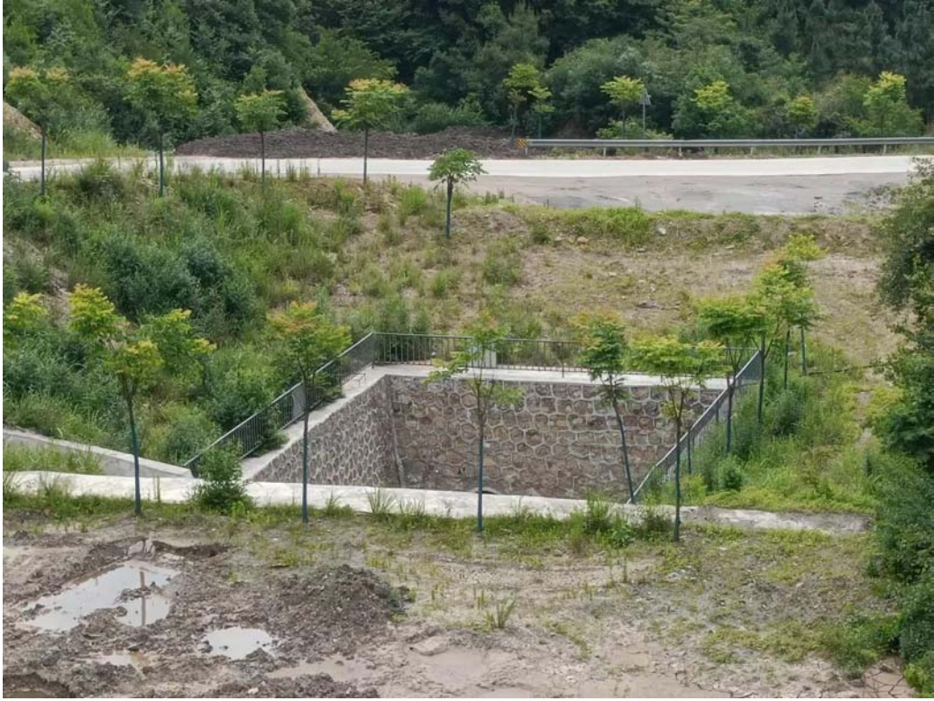
排土场区挡土墙、沉砂池
