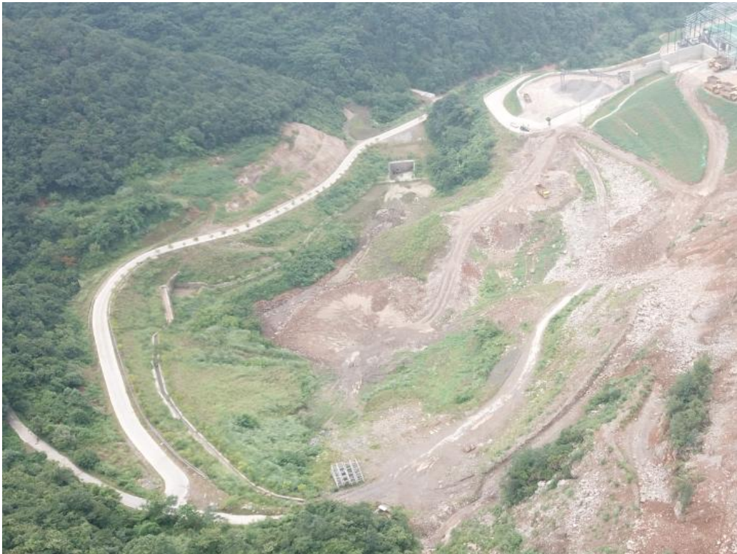
排土场区排水沟、沉砂池、绿化
