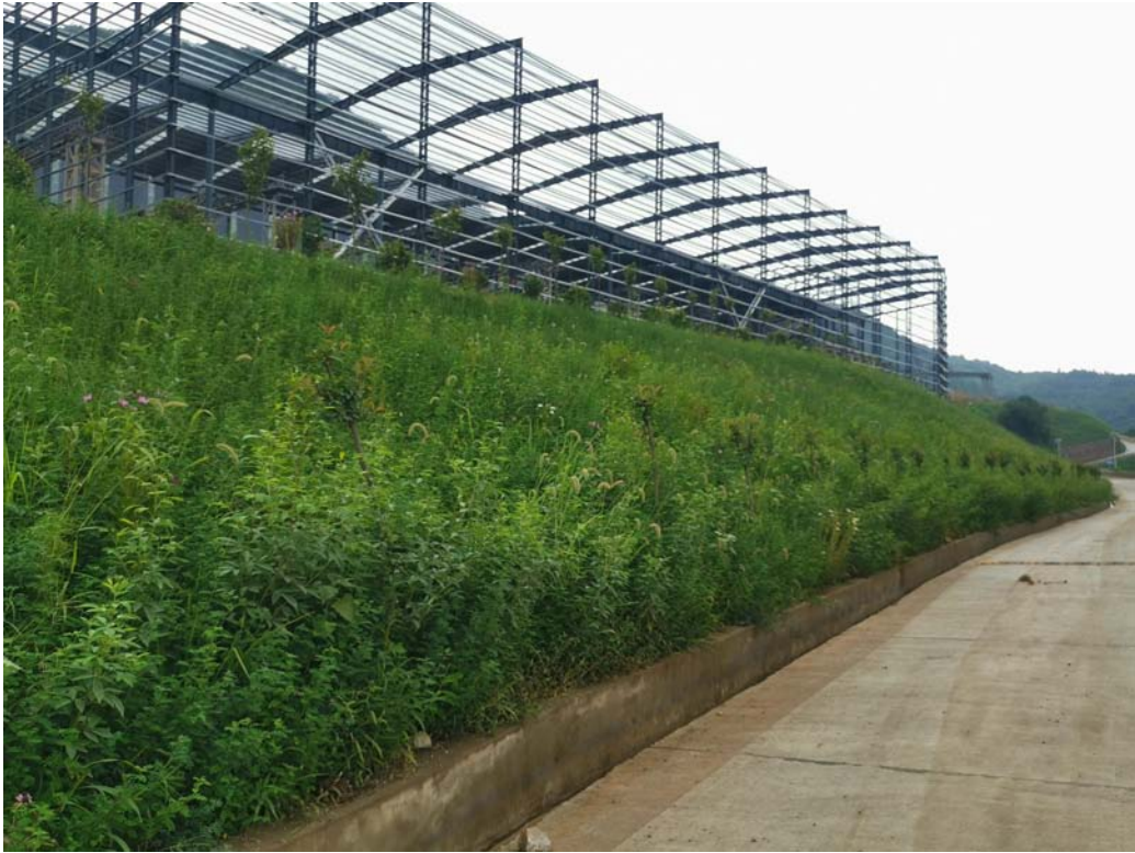
工业场地区排水沟、边坡绿化
