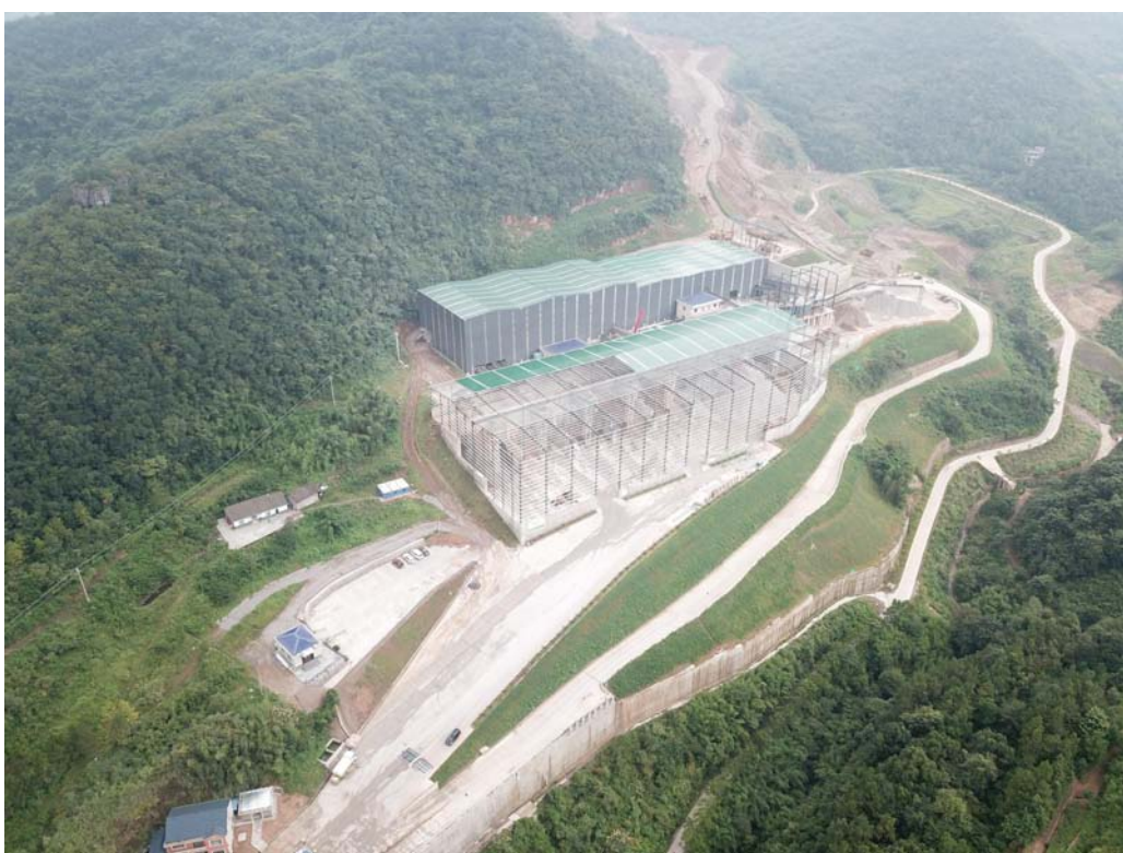
工业场地区、交通道路区硬化、排水沟、绿化措施
