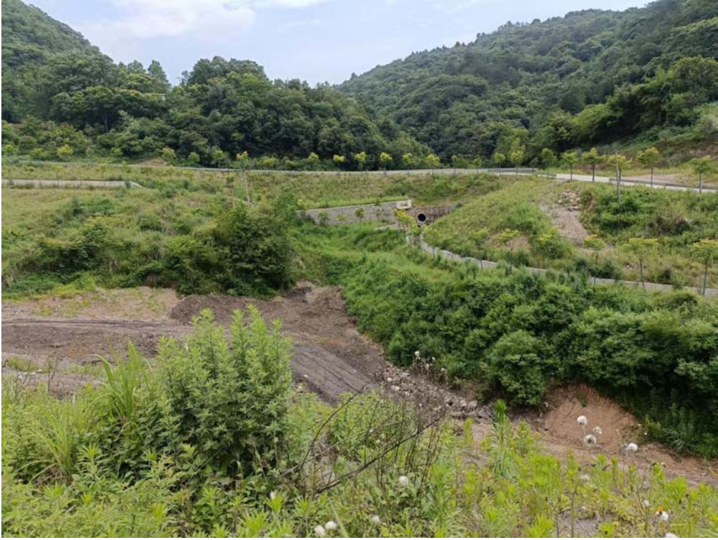
排土场区排水沟、绿化
