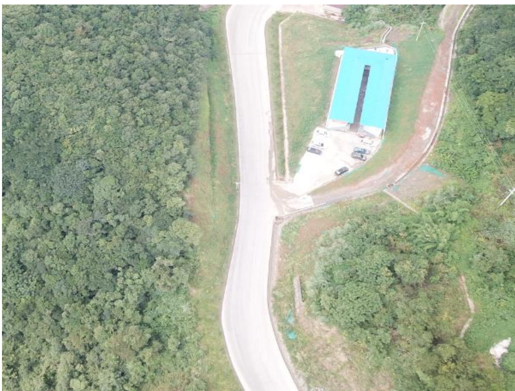
进口交通道路硬化、两侧排水沟、绿化措施
