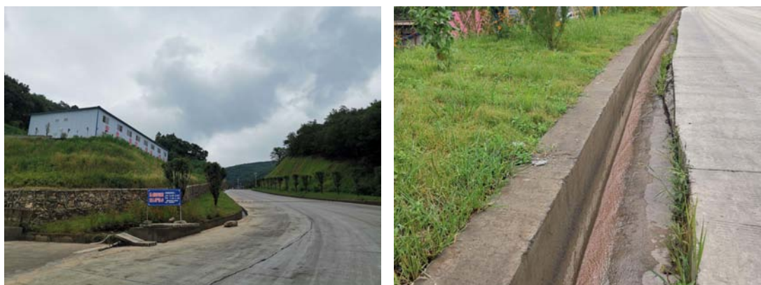
道路硬化、排水沟
