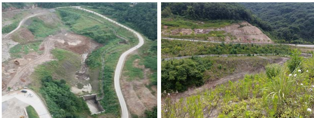
排土场排水沟、沉砂池、撒播草籽
